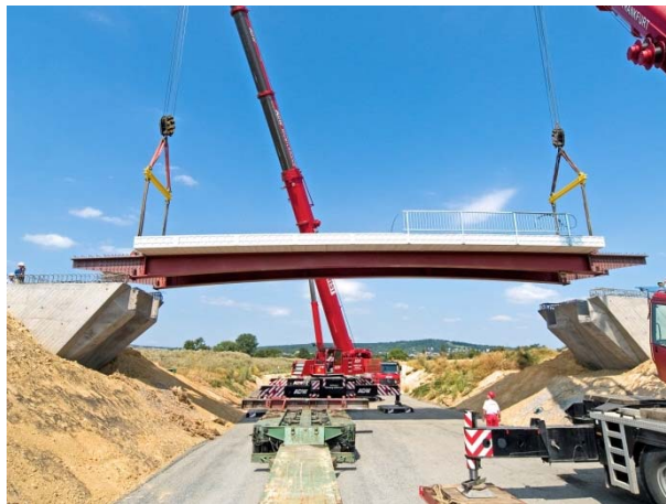
Figur 1. Friberg bron, består av stålbalkar med ett kolfiberdäck, lyfts till sin slutliga position efter transport till broläget.
