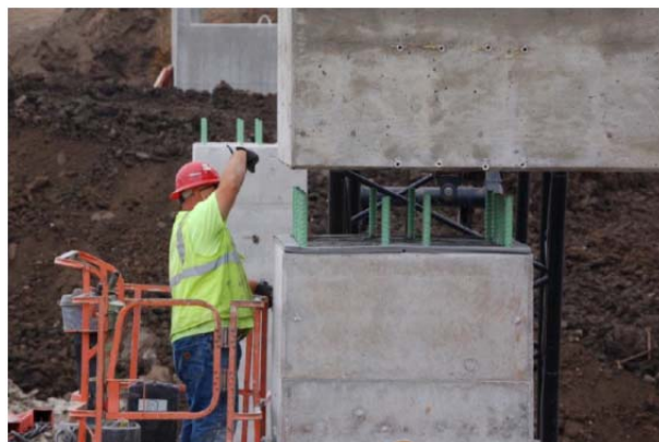
Figur 2. Montering av prefabricerade betong element som lyfts på plats och därmed snabbar upp byggprocessen och säkerställer en hög kvalitet på ingående komponenter.
